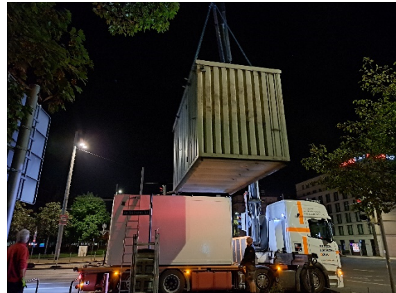
Abb. 4: Station Leipzig-Mitte: Nächtliche Umsetzung der Container.
