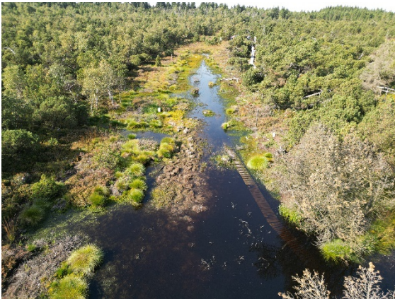
Abb. 16: Moorbereich nach Staumaßnahme.
