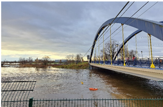
Abb. 6: Hochwasser Bad Dübener Mulde
